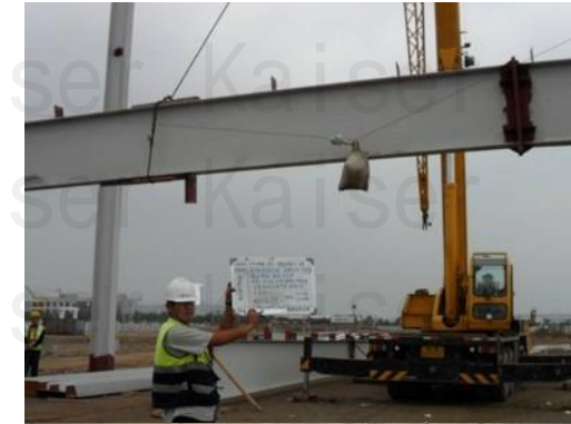
Life Line Test 生命线试验
