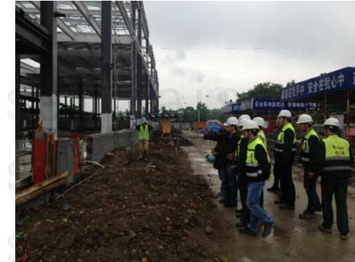
Project Daily Inspection 项目日常检查
